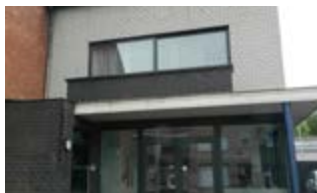
Frituur t Brugske Brugstraat 25
